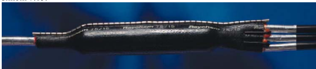
Slika 7.15. Završena termoskupljajuća spojnica
